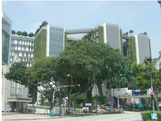
ภาพที่ 3 การจัดสวนแนวตั้งบนอาคารและสวนหลังคา ในประเทศสิงคโปร์
