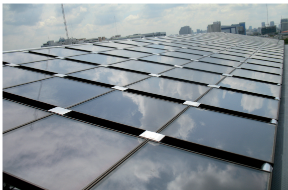
รูปที่ 2. ชุดแผงเซลล์แสงอาทิตย์ จำนวน 110 แผง
