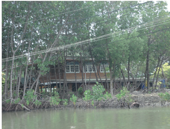
รูปที่ 11 การท่วมของระดับน้ำจากการทรุดตัวของดิน
