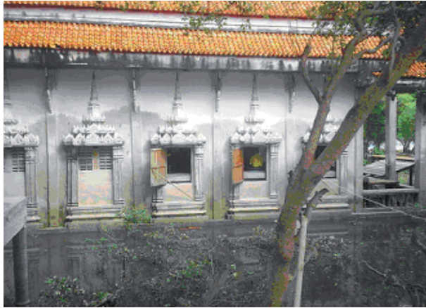
รูปที่ 2 การแก้ปัญหาของวัดขุนสมุทราวาสด้วยการโบกปูนปิดช่องหน้าต่างกันคลื่น
