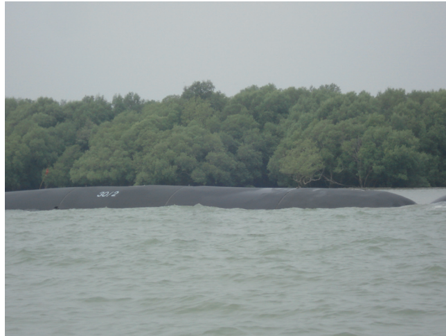
รูปที่ 16 การใช้ถุงทรายกันคลื่นลมและการท่ดตัว
