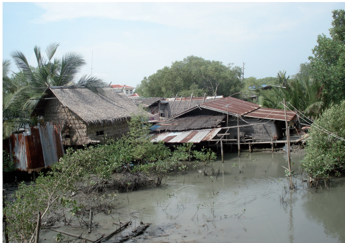
รูปที่ 13 การทรุดตัวของบ้านจากปัญหาแผ่นดินทรุด
