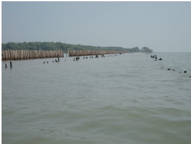
รูปที่ 15 ความล้มเหลวจากการใช้ไม้กั้นการกัดเซาะ
