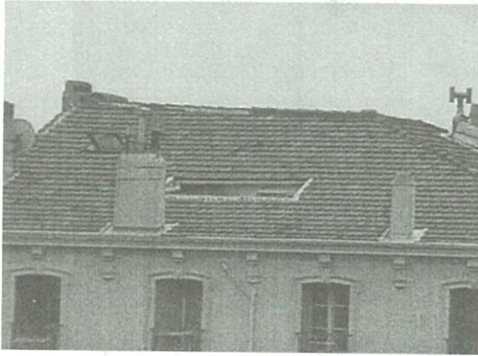
รูปที่ 6 แสดงลักษณะของการใช้การป้องกันความร้อนแบบทางอ้อมของบ้านในฝรั่งเศส
