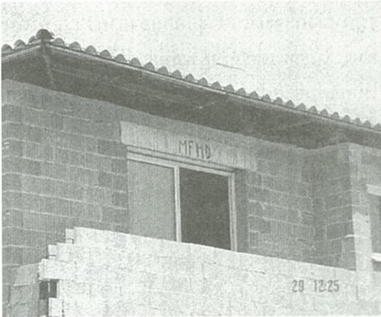
รูปที่ 4 แสดงลักษณะของอิฐบล็อกและการก่อผนังของบ้านพักอาศัยในฝรั่งเศสตอนใต้
