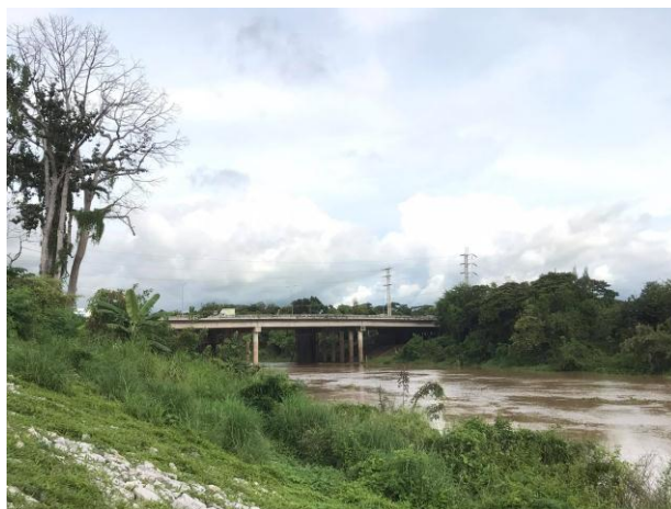
ภาพที่ 4 สะพานข้ามแม่น้ำชีอำเภอกันทรวิชัยในปัจจุบัน ภาพถ่ายโดย อิสระ สุธรรมราช เมื่อวันที่ 9 กันยายน พ.ศ. 2564
