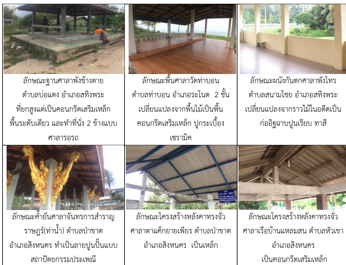
ภาพที่ 11 ลักษณะโครงสร้างของศาลากลางหนที่สร้างด้วยคอนกรีตเสริมเหล็ก
