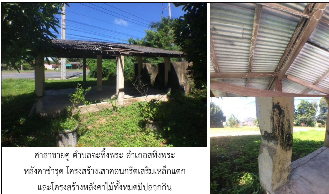
ภาพที่ 9 ลักษณะศาลากลางหนโครงสร้างคอนกรีตเสริมเหล็กที่มีสภาพทรุดโทรม
