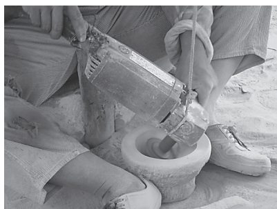
ภาพที่ 11 ลักษณะในการเจียรภายในของครกหินเพื่อให้มีความเรียบก่อนนำไปใช้งาน
