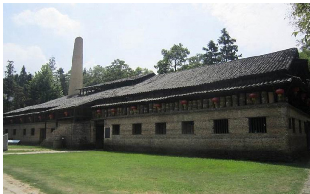
ภาพที่ 1 : เตาเผาเงินจะอยู่ภายในอาคารเรือนเตาโครงสร้างก่อด้วยอิฐผสมไม้ มุงหลังคาด้วยกระเบื้อง เตาเผาแบบประเพณีของจีนชนิดแบบที่มีปล่องเตามักอยู่ในอาคารเรือนเตาแบบนี้ทั้งสิ้น ซึ่งจะแตกต่างจากเตามังกรที่ใช้ลักษณะทางภูมิศาสตร์ในการก่อเป็นเตาเผา (ที่มา : 26 ก.ค. 2555)
