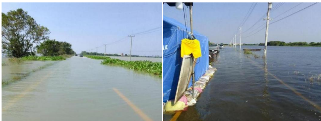
ภาพประกอบที่ 10 ปริมาณน้ำเต็มแก้มลิงทำให้น้ำท่วมทางหลวง 3412 และถนนคันกั้นน้ำในทุ่ง
