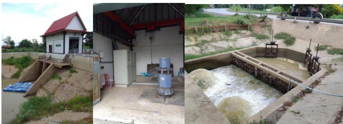
ภาพประกอบที่ 3 เครื่องจักรในโรงสูบน้ำสูบน้ำจากแม่น้ำไปยังคลองชลประทาน
