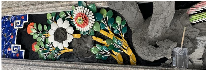
ภาพที่ 5 การฝังแบบลอยที่อยู่ระหว่างการสร้าง ที่มา: Liu Jian (2566)
