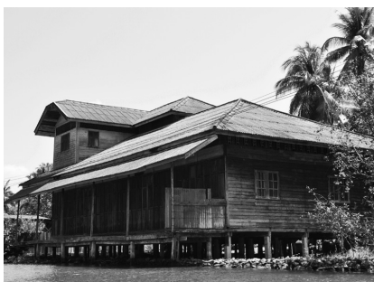
ภาพที่ 3 ลักษณะเรือนไทยหลังคามนิลาทรงเตี้ย
