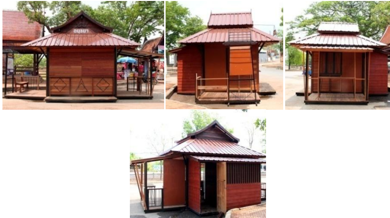
ภาพที่ 11 แสดงรูปแบบสภาพแวดล้อมทางกายภาพภายนอกของต้นแบบเรือนค้าขาย ทั้ง 4 ด้าน ที่มา : ภาพถ่ายโดย วิศิษฐ์ เพียรการค้า เมื่อวันที่ 2 พฤษภาคม พ.ศ. 2559
