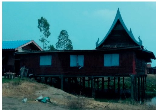
ภาพที่ 6 บ้านนางบุญนะ มาลาวงษ์ ขยายเรือนด้วยการทำหลังคาคลุมขนานตลอด
