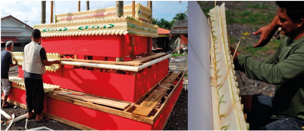
ภาพที่ 13 การประกอบติดตั้งกับโครงสร้าง
