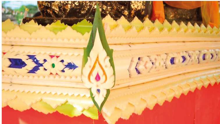
ภาพที่ 14 การติดตั้งลายปิดมุม
