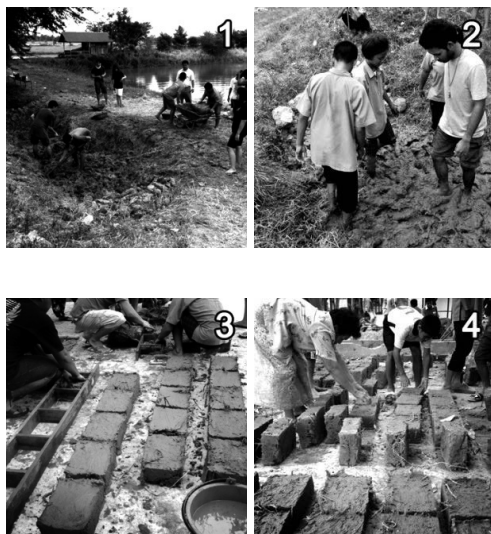
ภาพที่ 1 ขั้นตอนการทำอิฐดิน
