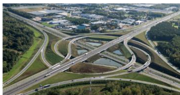
ทางแยกต่างระดับเชื่อมต่อ E313 และ E314 ในเมือง Lummen, Belgium
