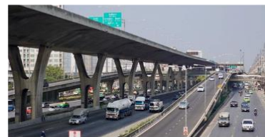
ทางคู่ขนานเชื่อมต่อกับด่านเก็บค่าผ่านทางบนถนนบูรพาวิถี
