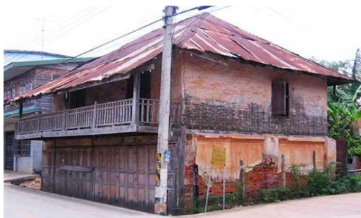
ภาพที่ 5 บ้านไม้ไผ่สานฉาบปูนที่สร้างขึ้นมาจากวัสดุที่มีอยู่ในท้องถิ่น
