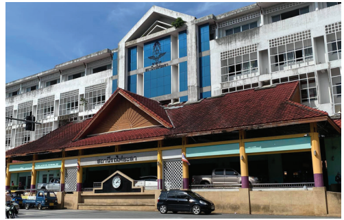
อาคารสถานียะลาลังปัจจุบัน (ที่มา ผู้เขียน)
