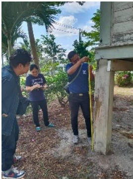
ภาพ 1-4 การตรวจวัดและประเมินสภาพโครงสร้างอาคารเดิมเพื่อเตรียมการปรับปรุง หมายเหตุ. ภาพถ่ายโดยผู้เขียน
