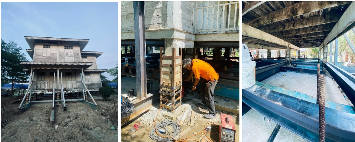
ภาพ 15-17 การดำเนินงานโครงสร้างถาวรและการเสริมความแข็งแรงของระบบรับน้ำหนัก หมายเหตุ. ภาพถ่ายโดยผู้เขียน
