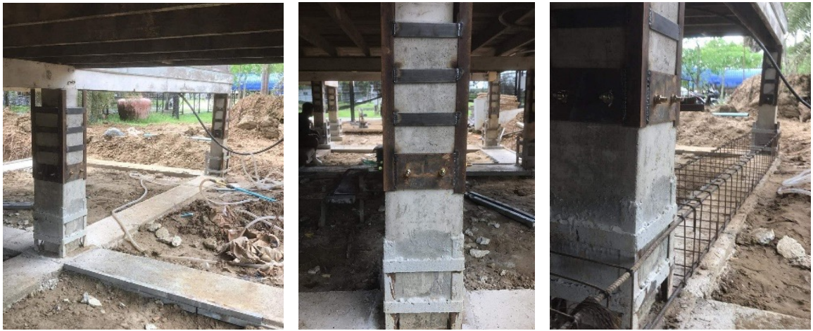
ภาพ 12-14 การติดตั้งระบบค้ำยันเพื่อรองรับโครงสร้างระหว่างการยกกระดับอาคาร หมายเหตุ. ภาพถ่ายโดยผู้เขียน
