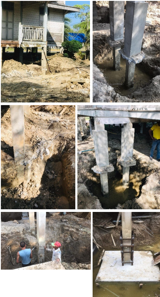
ภาพ 6-11 กระบวนการก่อสร้างและปรับปรุงฐานราก เพื่อเสริมความมั่นคงของโครงสร้าง หมายเหตุ. ภาพถ่ายโดยผู้เขียน
