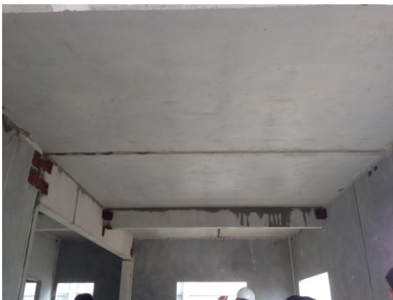
ภาพ 7 งานติดตั้งชิ้นส่วนคานและพื้น ชั้นบน
