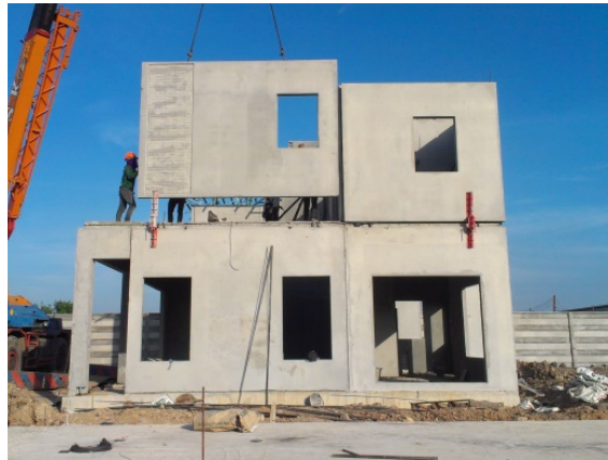
ภาพ 8 งานติดตั้งผนังชั้นบน
