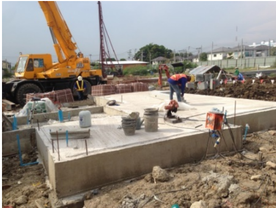
ภาพ 5 งานเทพื้นคอนกรีตหล่อกับที่ ชั้นล่าง
