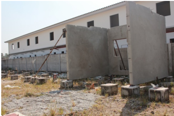
ภาพ 1 งานติดตั้งผนัง ชั้นล่าง
