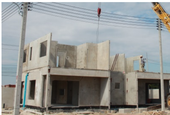
ภาพ 3 งานติดตั้งผนังชั้นบน
