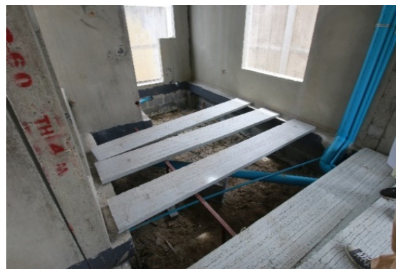
ภาพ 4 งานติดตั้งพื้นชั้นล่าง
