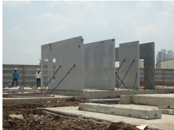
ภาพ 6 งานติดตั้งผนัง ชั้นล่าง
