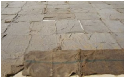
ภาพ 11 งานการบ่มคอนกรีตพื้นคอนกรีตหล่อในที่
