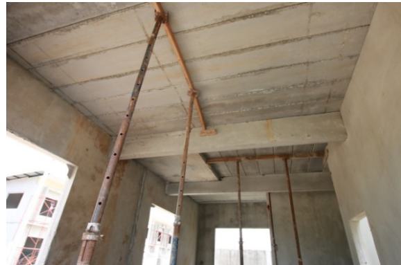
ภาพ 2 งานติดตั้งคานและพื้นชั้นบน
