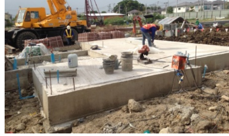
ภาพ 12 งานพื้นคอนกรีตหล่อในที่
