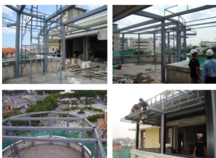
ภาพ 4 ภาพถ่ายแสดงพื้นที่ที่มีการต่อเติมชั้นดาดฟ้า
