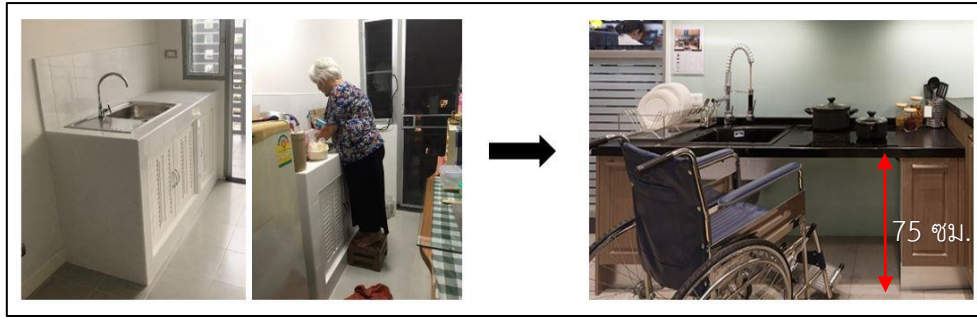
ภาพ 2 แสดงรูปแบบเฟอร์นิเจอร์เคาน์เตอร์ครัวในปัจจุบัน (ซ้าย) และรูปภาพตัวอย่างแนวทางออกแบบที่เหมาะสม (ขวา)
