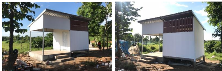
ภาพ 5 อาคารก่อสร้างแล้วเสร็จ
