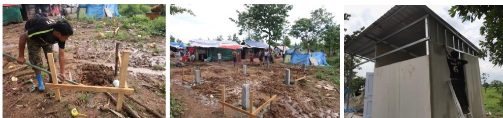
ภาพ 6 ปัญหาที่พบในขั้นตอนการก่อสร้าง (ซ้าย) งานขุดดินเพื่อเตรียมตั้งเสาต่อม่อ (กลาง) งานติดตั้งเสาต่อม่อ (ขวา) การติดตั้งแผ่นไฟเบอร์ซีเมนต์
