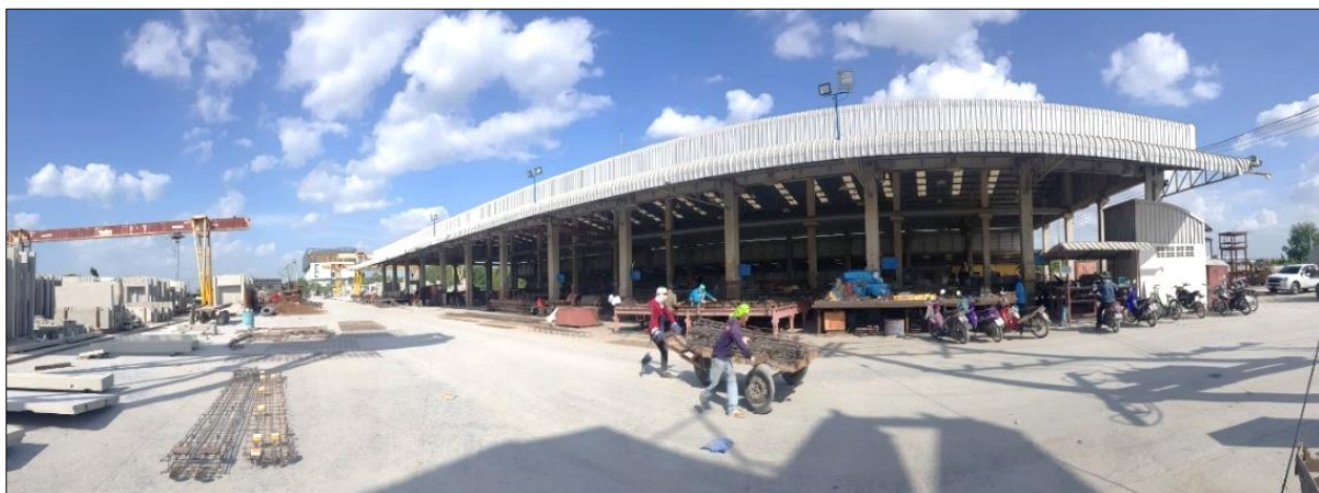
ภาพ 1 โรงงานผลิตผนังคอนกรีตสำเร็จรูป บจก.ซี-โพส
