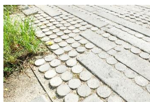
ภาพ 13-14 (ซ้าย)หัวเสาเข็มคอนกรีตเหลือทิ้งจากการก่อสร้างนำมาปูพื้นผิว (ขวา)ศาลาที่สร้างจากวัสดุไม้จากซากเรือเก่า
