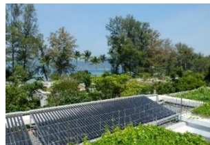
ภาพ 23-24 (ซ้าย)แผงพลังงานแสงอาทิตย์บนอาคารวิลล่าระดับที่3 (ขวา)แผงเครื่องทำน้ำอุ่นพลังงานแสงอาทิตย์บนอาคารวิลล่าระดับที่ 2
