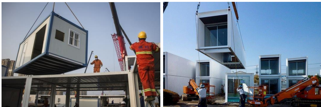
ภาพ 1 อาคารโครงสร้างเหล็กสำเร็จรูประบบกล่อง ในขั้นตอนการประกอบติดตั้ง ที่มา : สำนักข่าว BBC News สืบค้นเมื่อ 15 มีนาคม 2563
