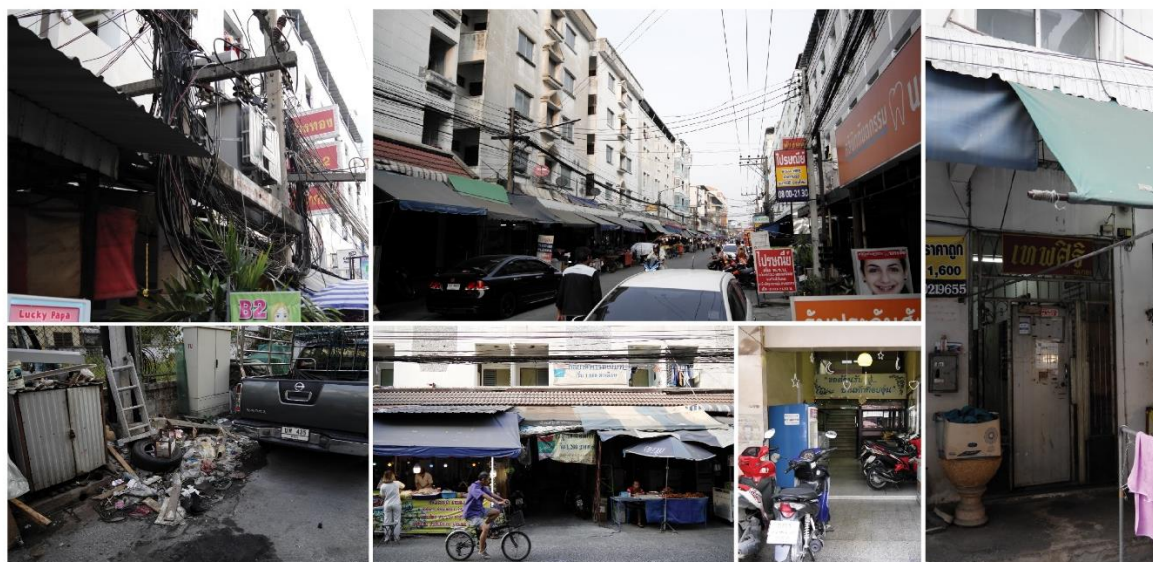
ภาพ 2 สภาพอะพาร์ตเมนต์ ภายในหมู่บ้านนครชัยมงคลวิลล์ จังหวัดปทุมธานี
