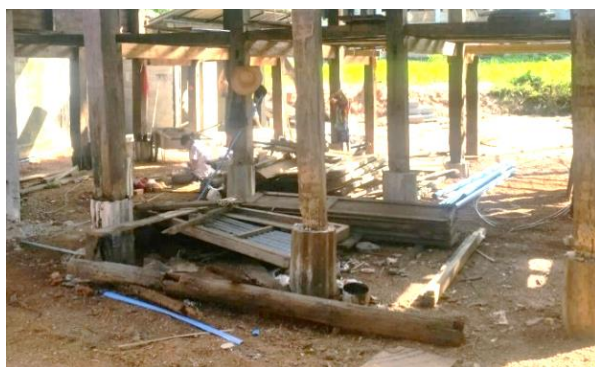
ภาพ 3 การซ่อมแซม และเสริมความแข็งแรงของโครงสร้างพื้น ด้วยการตัดเสาแล้วเปลี่ยนต่อม่อไม้เป็นคอนกรีต (ซ้าย)
