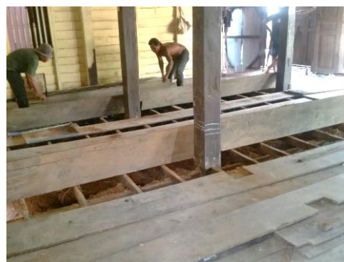
ภาพ 3 การซ่อมแซม และเสริมความแข็งแรงของโครงสร้างพื้น ด้วยการตัดเสาแล้วเปลี่ยนต่อม่อไม้เป็นคอนกรีต (ซ้าย)
