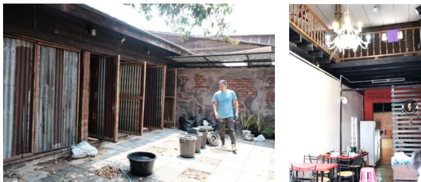
ภาพ 5 ภาพการดัดแปลงช่องเปิดเพื่อเชื่อมต่อพื้นที่ภายในกับภายนอก (ซ้าย) และภาพการเจาะพื้นเพื่อเชื่อมโยงพื้นที่โล่งทางตั้ง (ขวา) ที่มา: ผู้วิจัย
