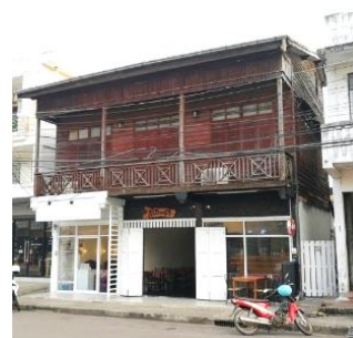
ภาพ 4 ลักษณะขององค์ประกอบภายนอกที่เป็นไม้เดิมซึ่งถูกซ่อมแซมคืนสภาพ (ซ้าย) การดัดแปลงองค์ประกอบภายนอกที่ต่อเติมภายหลังให้กลมกลืนกับองค์ประกอบเดิม (กลาง) และการดัดแปลงองค์ประกอบชั้นล่างที่ต่อเติมภายหลังให้ดูแตกต่างจากองค์ประกอบเดิมที่ชั้นสอง (ขวา)
