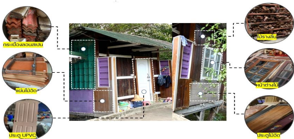
ภาพ 4 แสดงวัสดุก่อสร้างมือสองจากมูลนิธิสวนแก้ว ที่นำมาประยุกต์ใช้ในการก่อสร้าง
