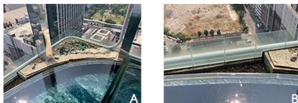
ภาพ 6 สภาพปัจจุบันของสวนหลังคาชั้น 42 โครงการ QCP
