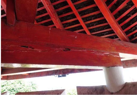
ภาพ 7 ซื่อไม้ขนาด 7x8 นิ้ว ซ่อนกันสองชั้นมีความผุร่อน ที่มา: ผู้วิจัย, 2563
