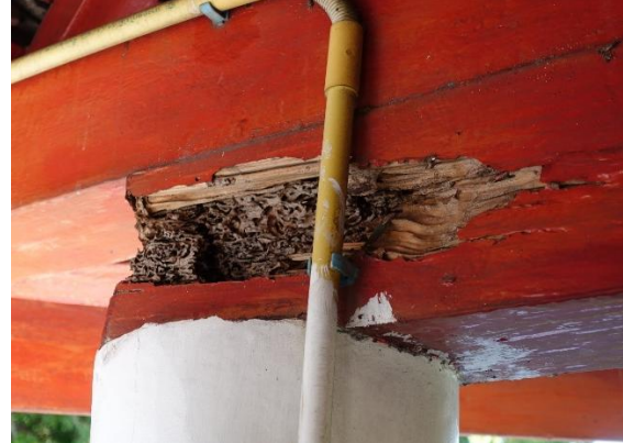
ภาพ 7 ซื่อไม้ขนาด 7x8 นิ้ว ซ่อนกันสองชั้นมีความผุร่อน ที่มา: ผู้วิจัย, 2563
