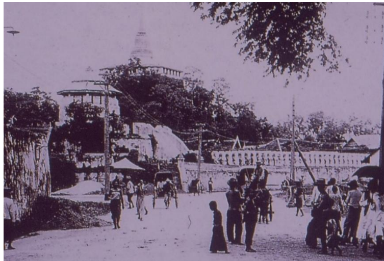
ภาพ 1 ป้อมมหากาฬจากภาพถ่ายในอดีต
