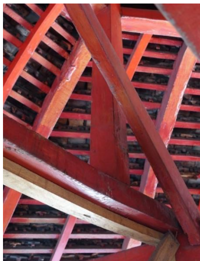
ภาพ 9 แสดงการแอ่นตัวของไม้รับจันทัน (ซ้าย) จันทันไม้ 4x4 นิ้ว ผุเป็นอย่างมาก (ขวา) ที่มา: ผู้วิจัย, 2563
