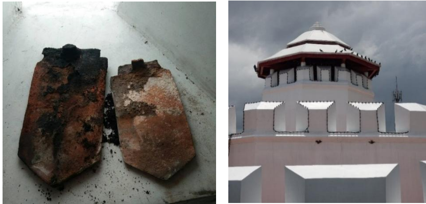
ภาพ 10 กระเบื้องดินเผาหลังคาเพื่อยุ่ยหมอดอายุการใช้งาน ทั้ง 2 ดับขนาดไม่เท่ากัน (ซ้าย) หลังคาฉาบปูนทับเหนือกระเบื้องดินเผา (ขวา) ที่มา: ผู้วิจัย, 2563
