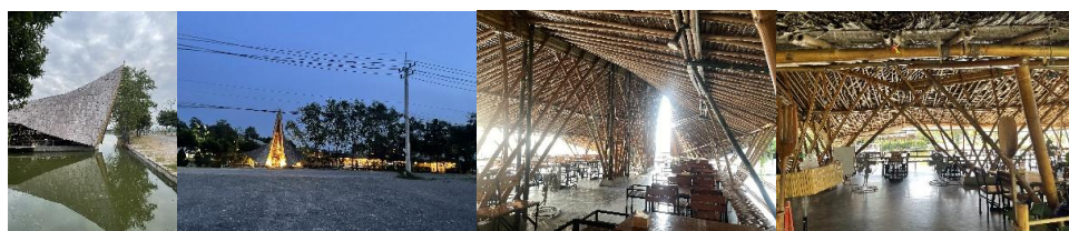
ภาพ 4 ลักษณะทางกายภาพของอาคารหลังที่ 1 ร้านข้าวใหม่ปลามัน
