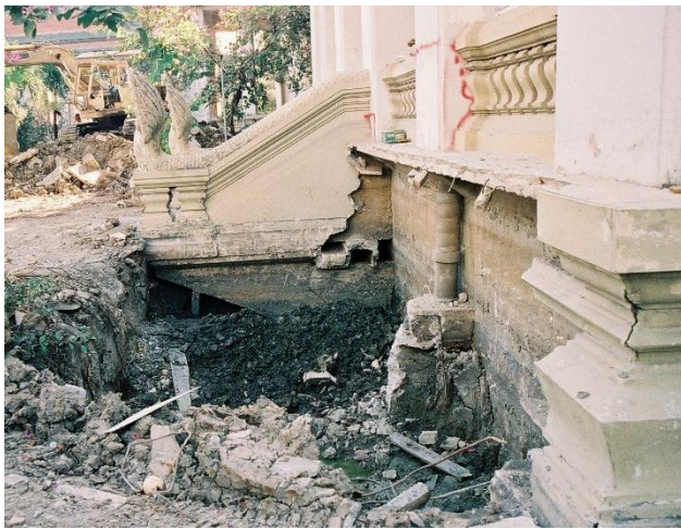
ภาพ 18 ภาพถ่ายการรื้อถอนซ่อมแซมฐานบัวอาคารในการปรับปรุงซ่อมแซม พ.ศ.2539-2542 แสดงให้เห็นถึงการใช้อาคาร ค.ส.ล. หล่อถอดพิมพ์ (Precast) ที่ประดับอยู่ในส่วนหน้าบันอาคารมุขประเจ็ดของหลังคา (Precast) ท่อระบายน้ำฝนและรางระบายน้ำของอาคารตั้งแต่สมัยแรกก่อสร้าง ที่มา : จาก หอประวัติจุฬาลงกรณ์มหาวิทยาลัย
