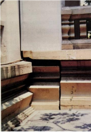
ภาพ 7 และภาพ 8 แสดงฐานบัวและเสาของอาคารมหาจุฬาลงกรณ์ที่ชำรุด เนื่องจากปัญหาการทรุดตัวของอาคาร
