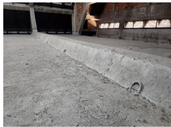
ภาพ 15 แนวข้อของอาคารบริเวณพื้นใต้หลังคาที่มีการหล่อคาน
