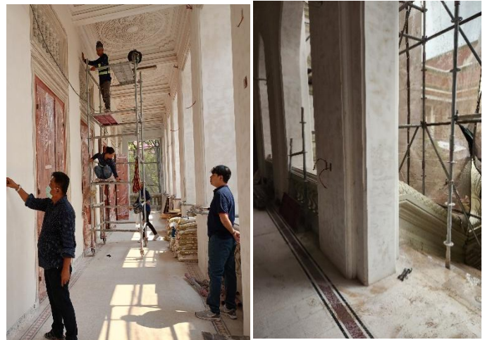
ภาพ 25 และภาพ 26 การสกัดผิวปูนฉาบเดิมซึ่งเสื่อมสภาพ ฉาบผิวใหม่ด้วยปูนฉาบสำหรับงานอนุรักษ์อาคาร เพื่อให้ผนังสามารถระบายความชื้นได้ดีกว่าปูนฉาบทั่วไป
