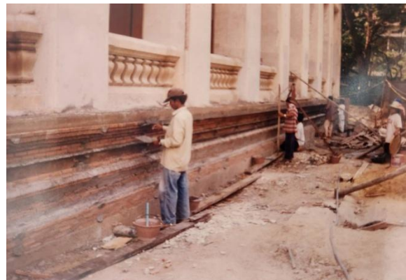
ภาพ 22 ภาพถ่ายแสดงการก่ออิฐปูนฐานอาคารใหม่
