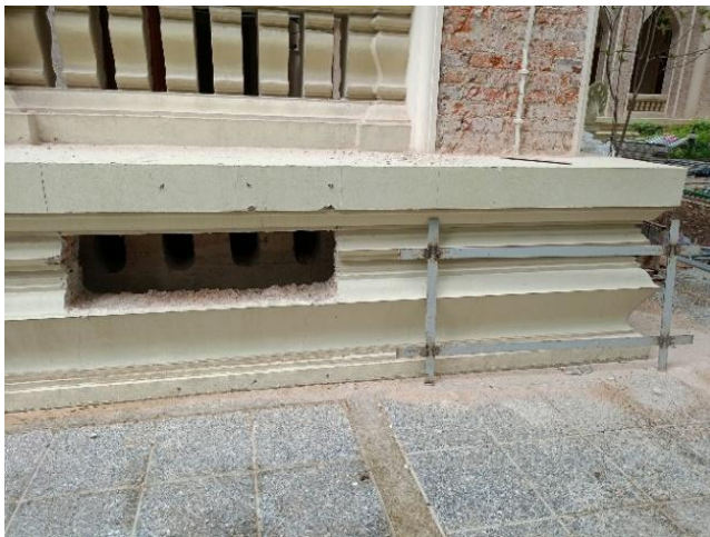
ภาพ 24 ภาพถ่ายแสดงการเจาะช่องระบายอากาศส่วนฐานเพื่อระบายความชื้นในส่วนฐานของอาคารมหาจุฬาลงกรณ์
