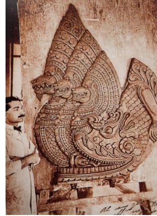
ภาพ 4 รัชกาลที่ 6 เสด็จพระราชดำเนินวางศิลาฤกษ์อาคารมหาจุฬาลงกรณ์ ภาพ 5 และภาพ 6 งานปั้นต้นแบบก่อนทำพิมพ์สำหรับงานปูนปั้นหล่อถอดพิมพ์ ในขณะที่ยังก่อสร้างอาคารอยู่ทำให้เห็นลักษณะโครงสร้างและวัสดุต่าง ๆ ที่ใช้ ที่มา : จาก Italians at the Court of Siam โดย The Embassy of Italy & ที่มา : จาก หอดจดหมายเหตุแห่งชาติ Ministry of Culture of the Kingdom of Thailand, 2008. Amarin. หน้า 231.
