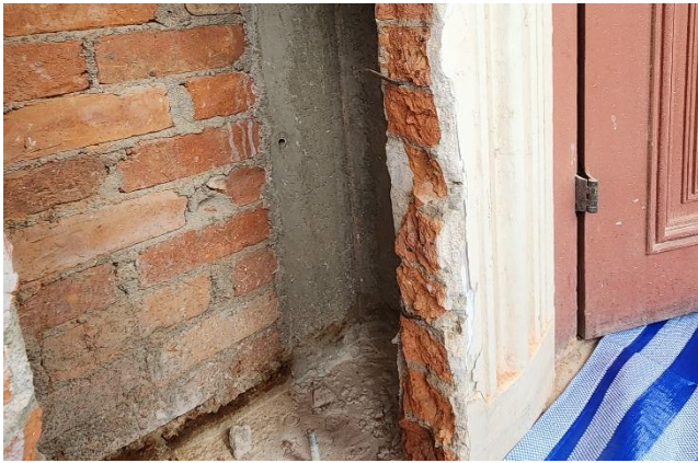
ภาพ 16 ภาพแสดงบัววงกบ ค.ส.ล. หล่อถอดพิมพ์ (Precast) ที่มีการติดตั้งก่อนแล้วจึงก่ออิฐไปชน โดยมีเหล็กหนวดกุ้งคอยยึดอิฐเป็นระยะตลอดแนววงกบ ที่มา : ผู้วิจัย
