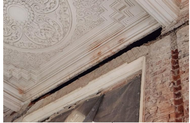
ภาพ 17 ภาพแสดงให้เห็นช่องว่างภายในที่กลวงของทับหลังคานซุ้มคูหาแสดงให้ระบบการติดตั้งแบบ ค.ส.ล. หล่อถอดพิมพ์ (Precast) ซึ่งไม่มีแนวคานโดยรอบระเบียงชั้นที่ 2 แต่ใช้วิธีการยื่นคานออกไป ที่มา : ผู้วิจัย
