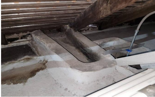
ภาพ 10 ภาพรางระบายน้ำที่เชื่อมต่อกับหัวกะโหลกแล้วระบายลงช่องท่อในเสาโดยรอบอาคาร ปัจจุบันได้ยกเลิกการระบายน้ำผ่านรางน้ำเหล่านี้ ที่มา : ผู้วิจัย
