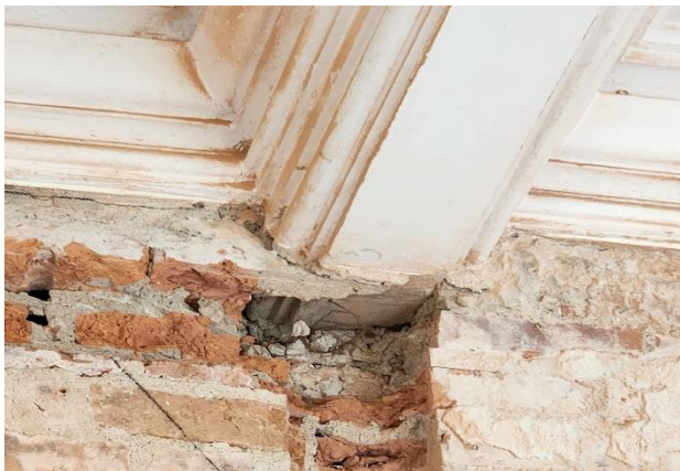
ภาพ 14 ภาพถ่ายการซ่อมแซมผิวอาคารและกริดแนวมผนังเพื่อวางแนว
