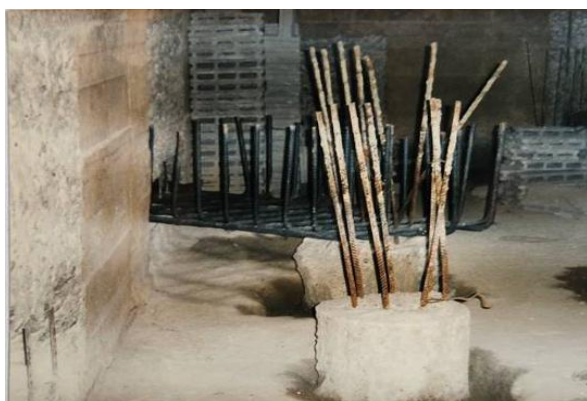
ภาพ 21 ภาพถ่ายแสดงการเสริมเข็มเจาะและฐานรากใหม่
