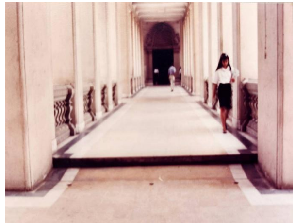
ภาพ 9 ภาพพื้นบริเวณโถงทางเข้ามุขกลางของอาคารมหาจุฬาลงกรณ์ ที่มีความเสียหายเนื่องจากการทรุดตัวของอาคาร
