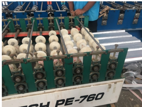
ภาพ 3 การรีดฉนวน PE ติดกับแผ่นเหล็กมุงหลังคาโดยใช้เครื่องรีด
