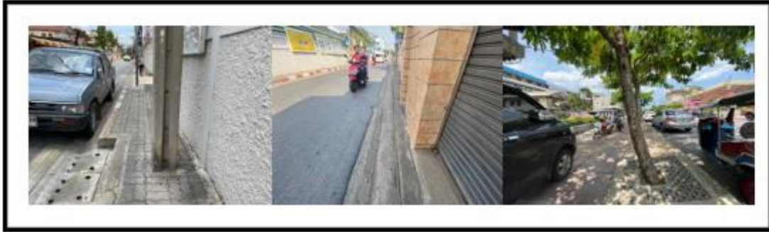
ภาพ 4 ทางเท้าที่ขรุขระ ความกว้างไม่ได้มาตรฐาน มีสิ่งกีดขวางบนทางเท้า ที่มา: ผู้วิจัย
