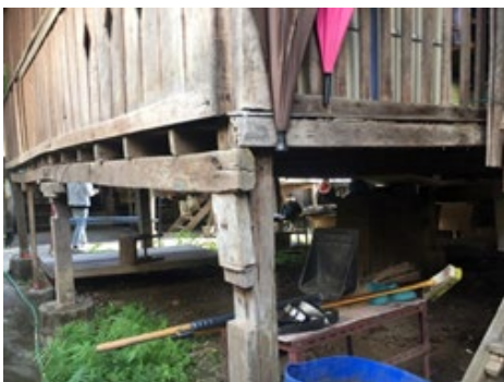
ภาพที่ 2 ที่อยู่อาศัยที่ทำด้วยโครงสร้างไม้
