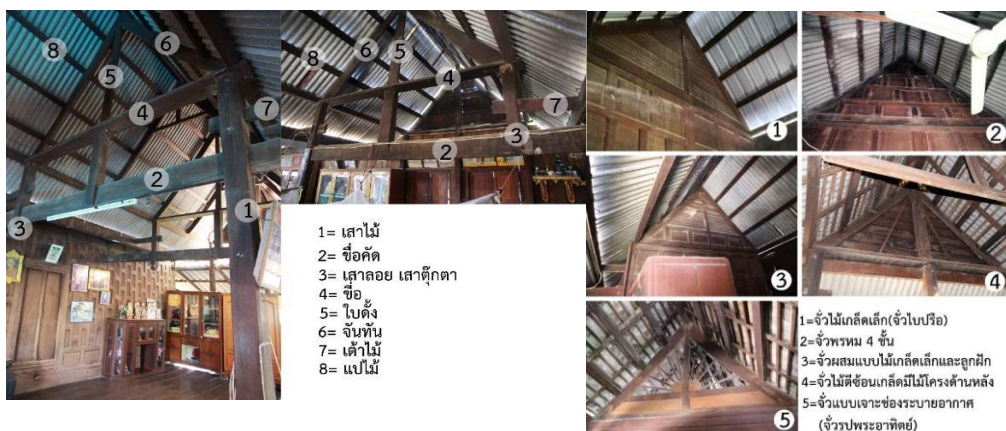
ภาพที่ 10 ซ้าย: โครงสร้างหลังคาเรือนกรณีศึกษา ขวา: รูปแบบหน้าจั่วหลังคาเรือนกรณีศึกษา
