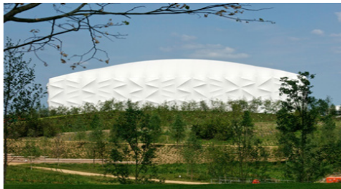
ภาพที่ 3 Basketball Arena โครงสร้างของอาคารสามารถพับเก็บได้
