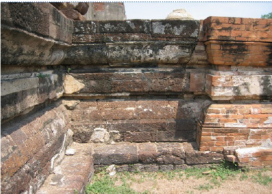
ภาพที่ 18 รอยเชื่อมที่ส่วนฐานระหว่างปรางค์ประธานกับปีกปรางค์องค์ทิศใต้ที่ปรางค์ประธานวัดพระศรีรัตนมหาธาตุ ลพบุรี (มุมมองจากด้านทิศตะวันตก)
