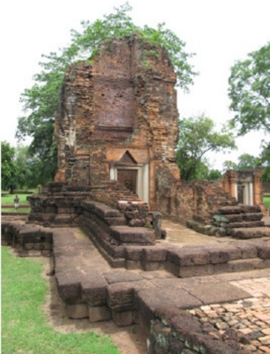
ภาพที่ 22 แนวทางเดินที่ก่อขึ้นใหม่ ทับช่องบันไดของปราสาท ประธานเอาไว้ที่ปราสาทสองพี่น้อง เมืองศรีเทพ จังหวัดเพชรบูรณ์
